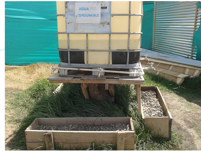
Sistema de Filtración de Agua, Proyecto ABB Tunal (Bogotá)
