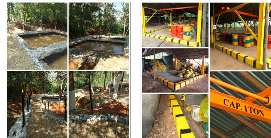
Humedal Artificial de Flujo Subsuperficial - Manejo de Lixiviados - Almacenamiento transitorio de Residuos Peligrosos
