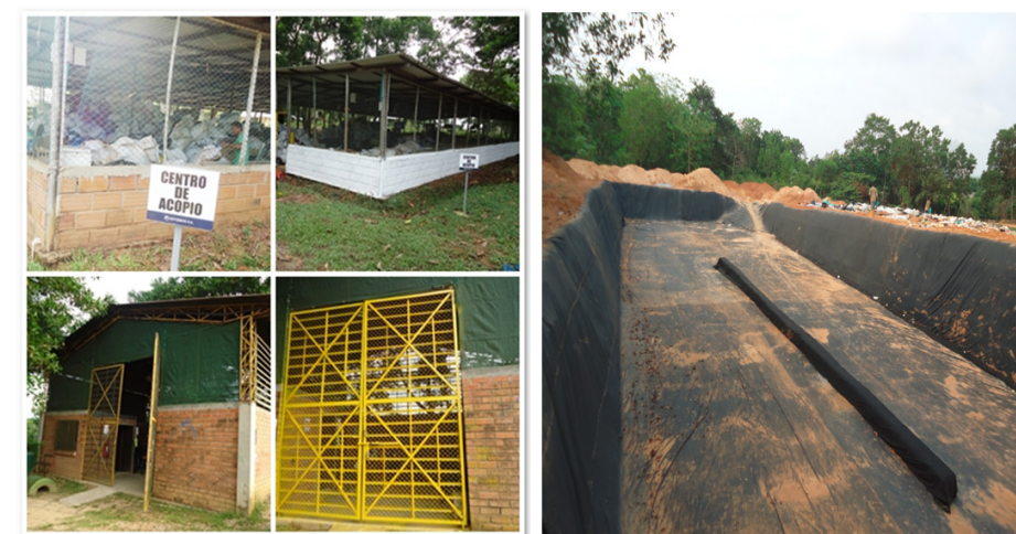
Centro de Acopio de Material Reciclable - Trincheras para el Almacenamiento de Residuos Ordinarios (2014 - 2017)
